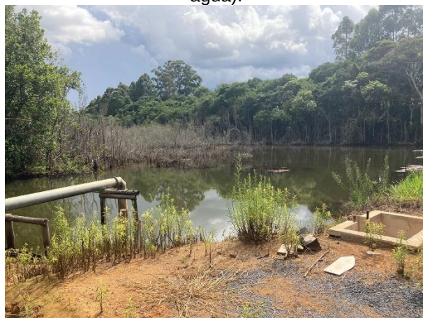
Figura 09: Barramento (Ponto de captação de água).
