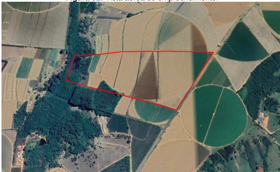
Figura 01: Vista aérea do empreendimento.
